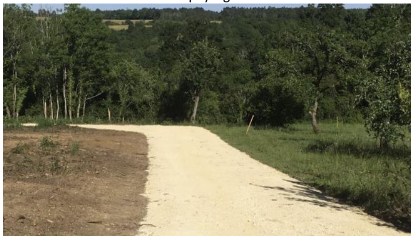
Figure 8 - Cheminement en GNT calcaire 0/10
