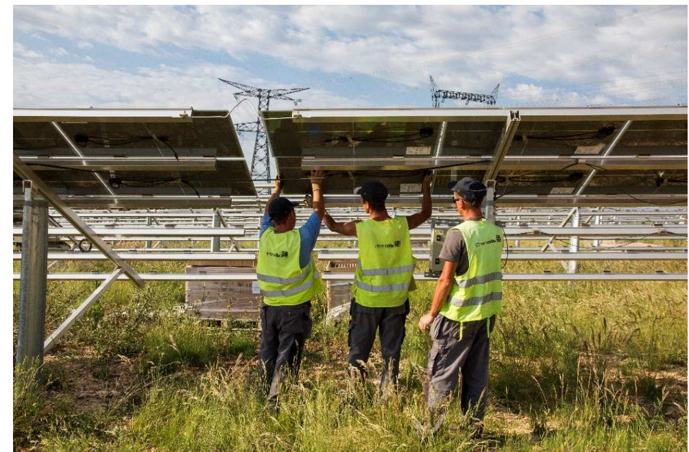
Illustration 12 : Pose de modules
