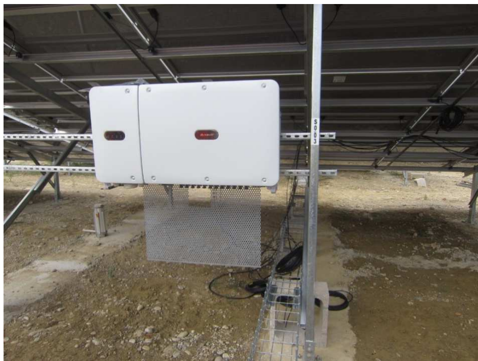
Illustration 5 : Exemple d'onduleur décentralisé
