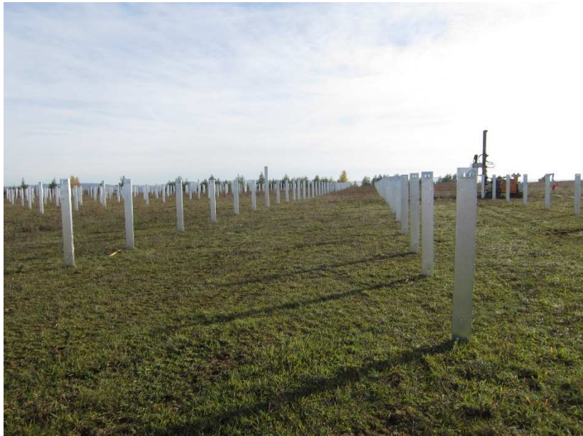
Illustration 10 : Exemple de pieux battus dans le sol avec une batteuse visible en arrière-plan
