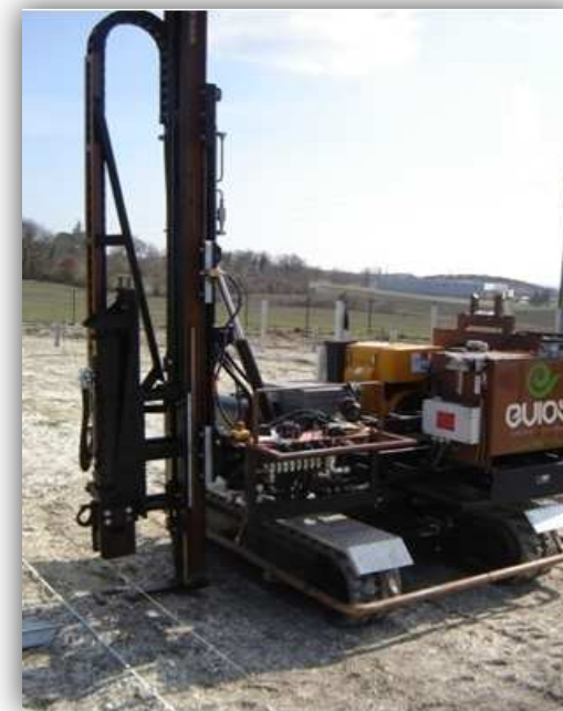
Engin de battage de pieux
