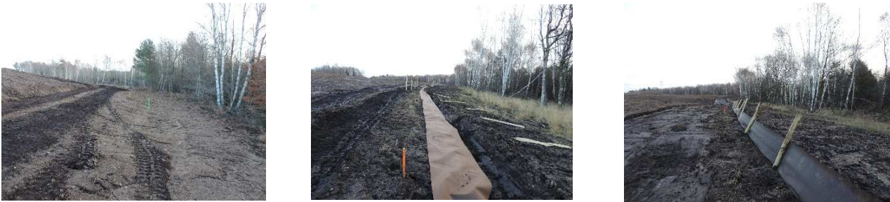
Les différentes phases de la pose de la clôture anti-intrusion (exemple).
