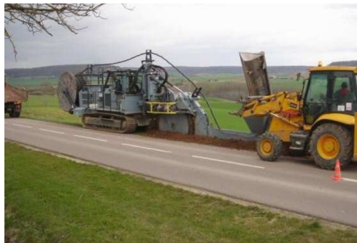
Illustration 7 : Réalisation d'une tranchée
