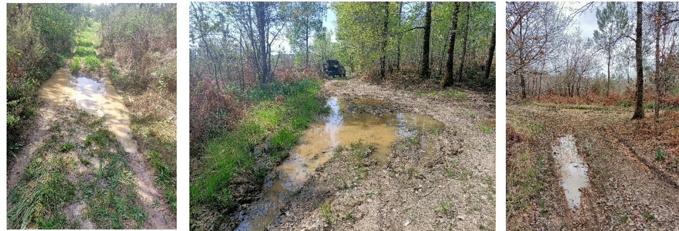
Ornière sur le chemin en limite Est.
