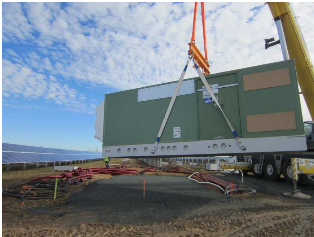
Illustration 13 : Exemple d'installation de poste de conversion
