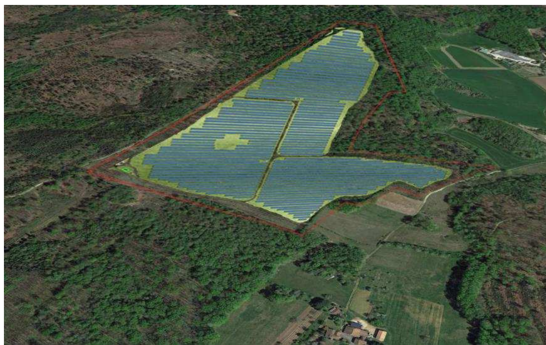
Vue oblique 2, en situation presque verticale, montre le projet à l'échelle du site sur l'Aire d'Etude Immédiate (AEI).
