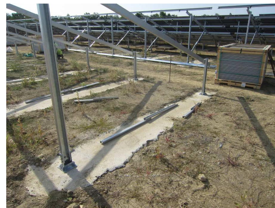
Illustration 2 : Exemple de longrine béton enterré
