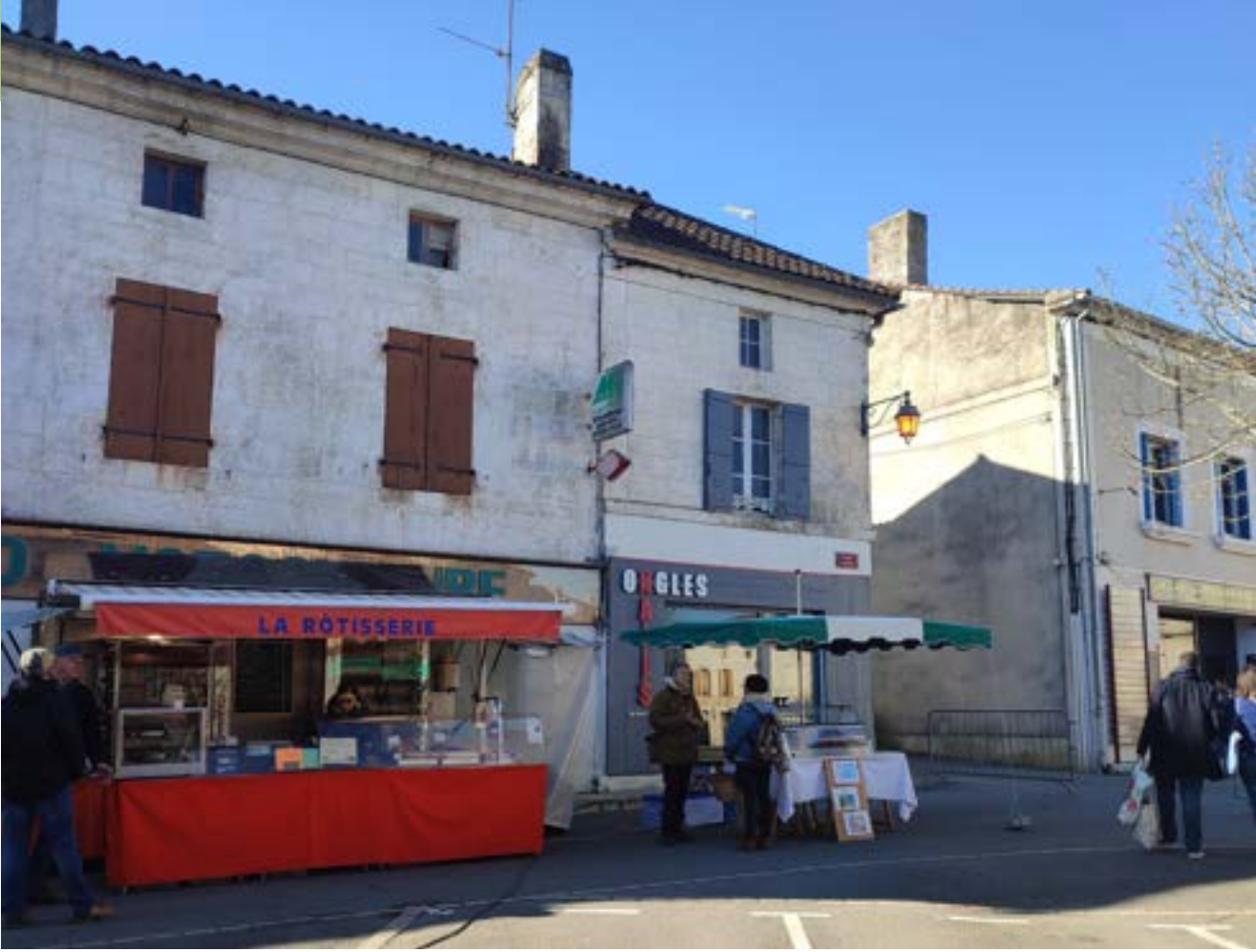
PLACE DU MARCHÉ AU CENTRE-BOURG Des maisons de villes étroites aux façades de calcaire ordonnancées au XVIIIème. Les devantures commerciales homogènes sur la place cachent une réelle hétérogénéité des constructions annexes dans la profondeur des parcelles.
