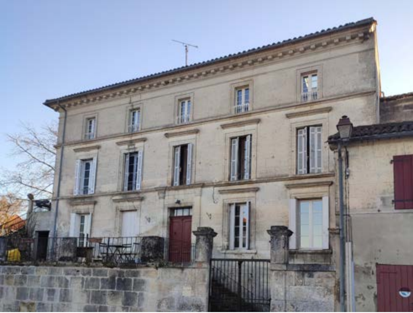
RUE DE PÉRIGUEUX Des maisons de maîtres plus imposantes, en retrait et en surplomb de la rue, proposent des espaces habités nobles côté rue et privés côté jardin.
