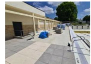
Principe dalles sur plots
