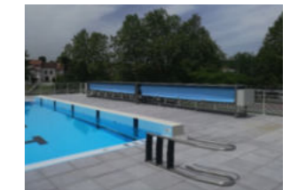
Bâche (couverture bassin)
