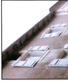
Linteaux des fenêtres cintrés, avec l'arrête extérieure courbe et l'arrête intérieure droite (façade 18ème s.)
