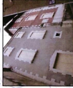
Traitement des façades caractéristique fin 19ème/début 20ème, avec les chaînes d'angles et les encadrements de baies formant des harpages très réguliers et saillants.
