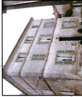
Niveau de comble traité en étage d'attique (début 19 e siècle)
