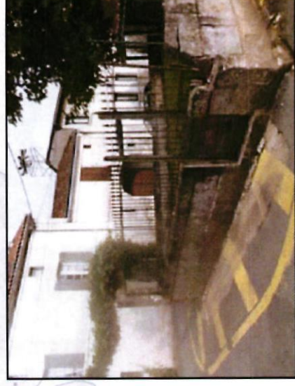
Muret avec soubassement en pierre de taille et grille métallique
