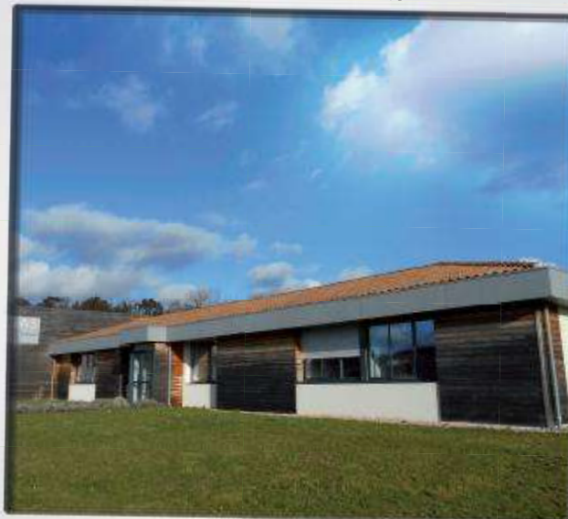
Dans le cadre d'une mutualisation, depuis le 1er novembre 2015 le service administratif de la communauté de communes a été transféré dans les locaux du CIAS ZAE Pierre Levée - 24310 Brantôme en Périgord
