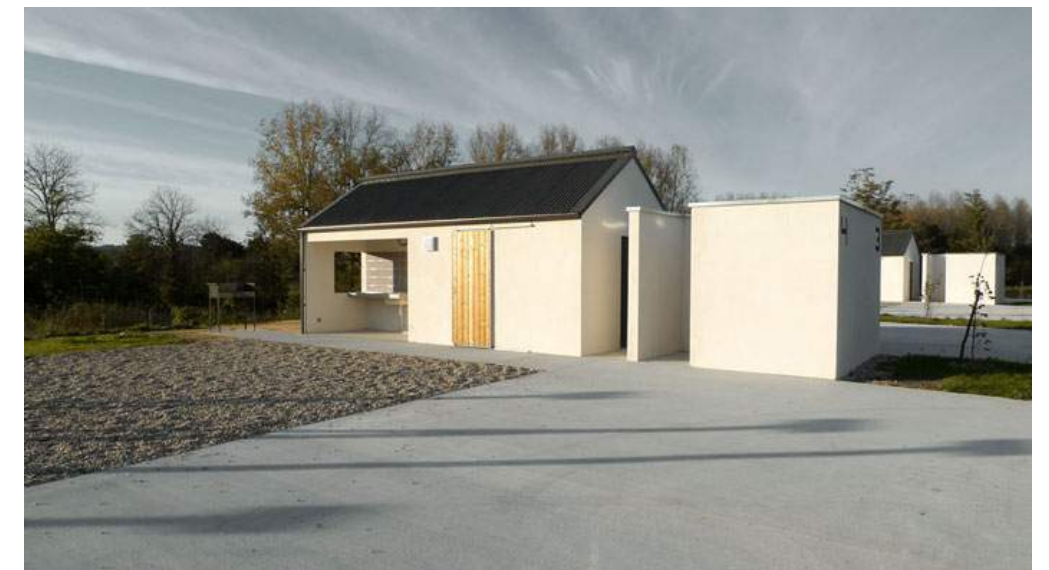
Exemples de modules sanitaires.
