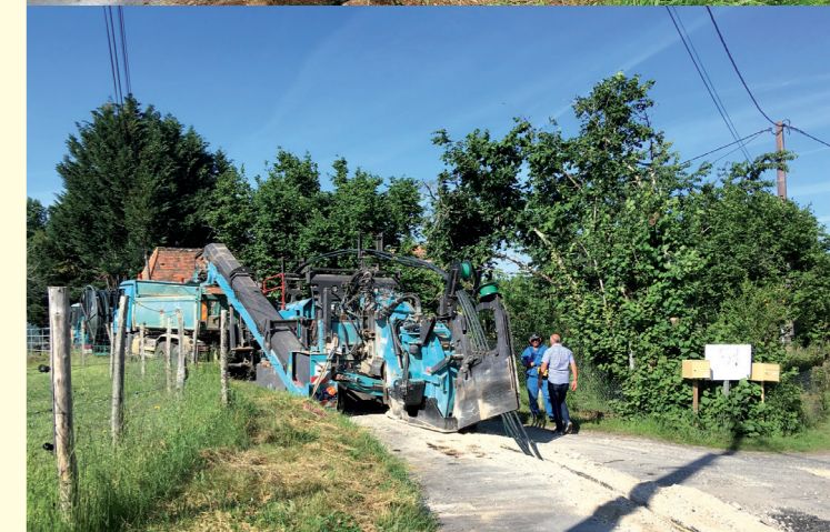
Opérations de construction du réseau de collecte et de fibrage sur le Département. | © SM Périgord Numérique
