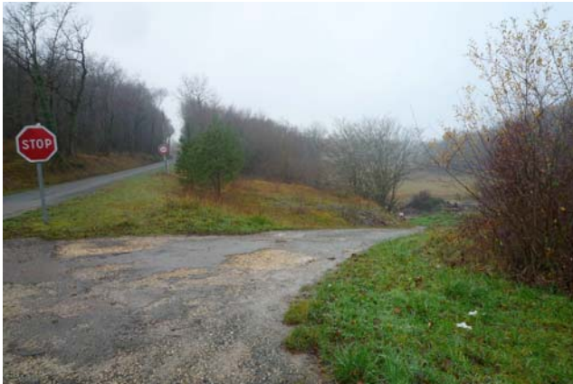
Voie d'accès au site à élargir
