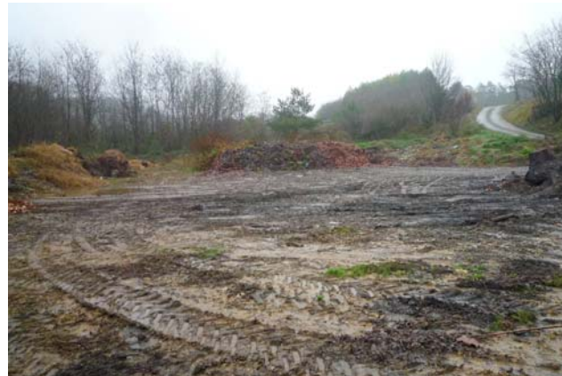
Un nettoyage du site est à réaliser
